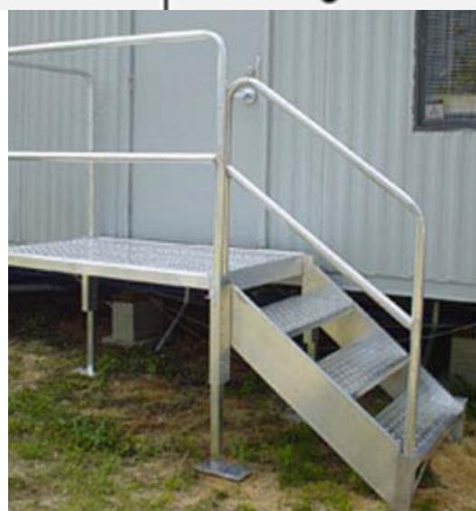
شکل ۳- نرده حفاظتی پلکان
